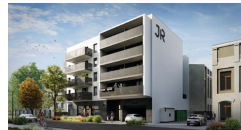
Widok od ul. Nowej
